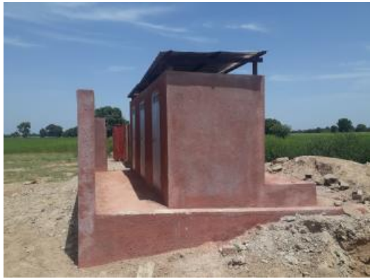
Latrines construites dans l'école de Wolokoro
